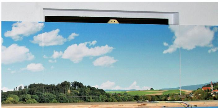
Eine abnehmbare Platten-Unterkonstruktion (zB. mit Magnethalterung) gewährleistet die Erreichbarkeit des Fensters und überzeugt mit einer durchgehenden Bildwirkung. Zu sehen ist lediglich eine feine umlaufende Schnittkante entlang der Fensternische.
